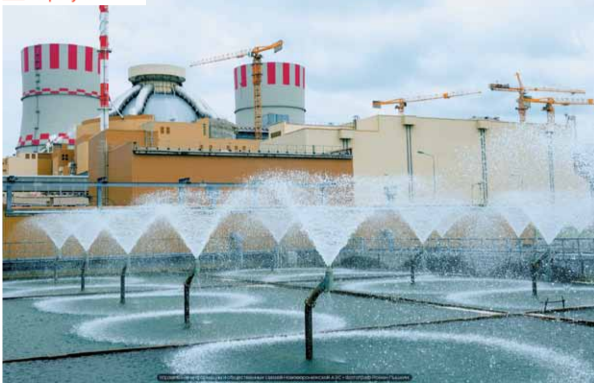
Новый блок Новovorонeжской АЭС-2. Фото: Роман ПЫШКИН
