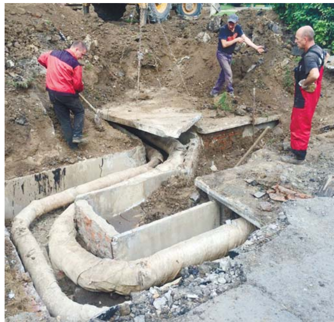
Ремонт трубопровода в самом разгаре
