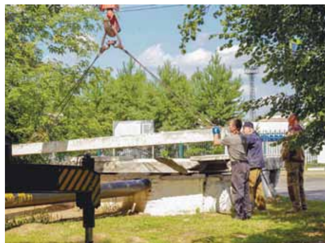
Ремонт труб на улице Космонавтов
