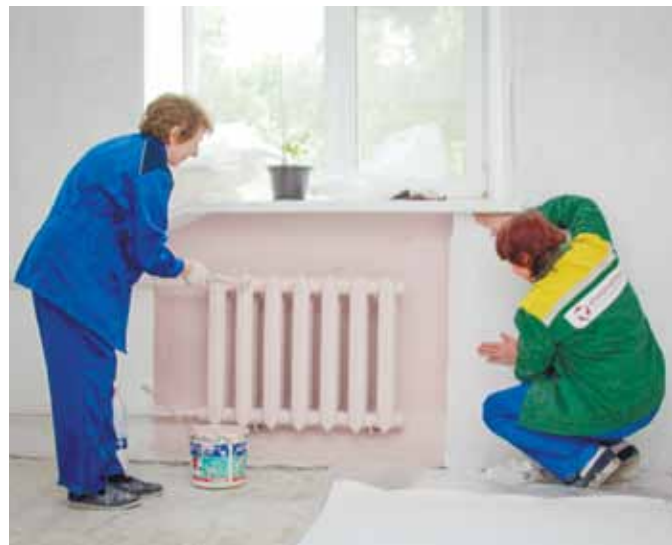
Ремонт комнат в общежитии
