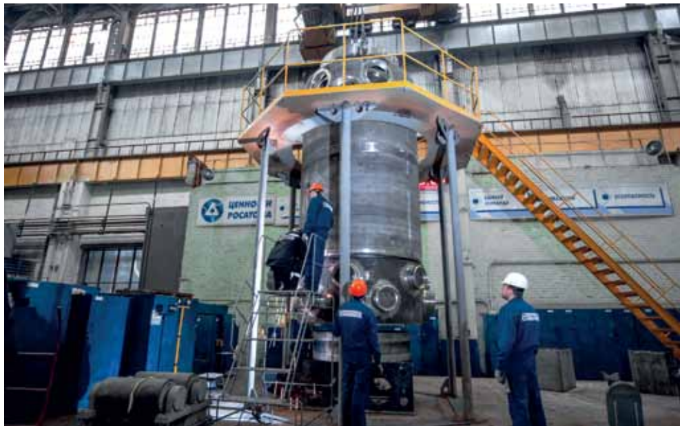
Предварительная сборка обечайки с трубным пучком испарителя этана
