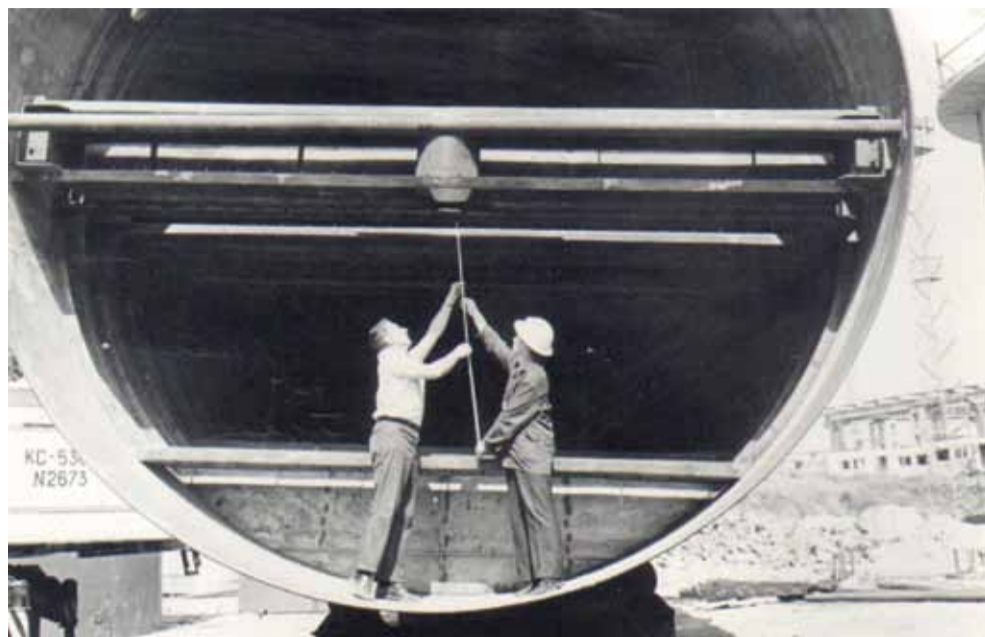
Трудков Геннадий и Барышев Михаил проверяют расстояние между клапанными «тарелками» ректификационной колонны диаметром 5,5 м, г. Бургас, 1977 или 1978 г.
