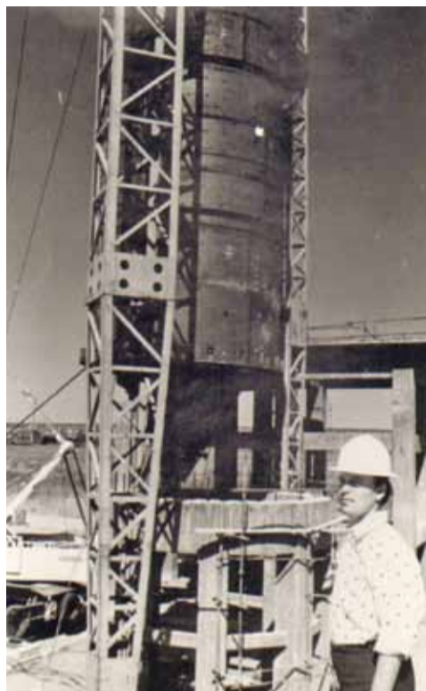
Установка колонны К-201 на фундамент, сентябрь 1977 г.
