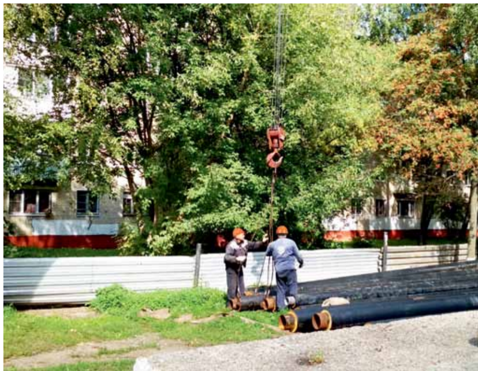
Замена трубопровода на ул. Машиностроителей, д. 26
