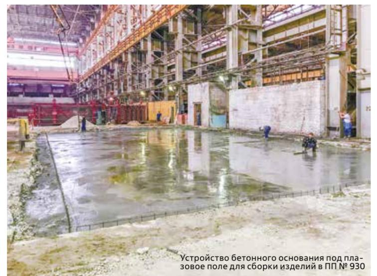
Устройство бетонного основания под плазменное поле для сборки изделий в ПП № 930
