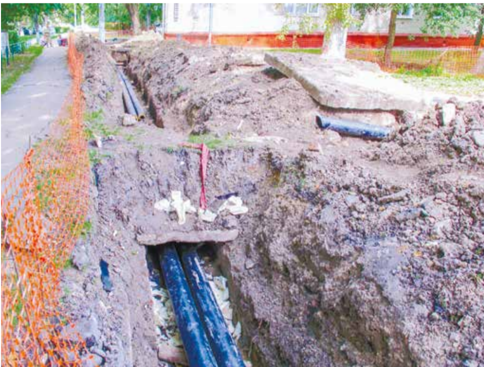
← Замена трубопровода на ул. Молодёжной, д. 13, 15
