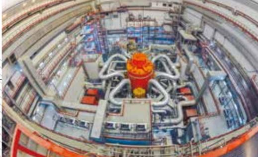
Пуск четвёртого блока Белоярской АЭС с РУ БН-800. Завод изготовил корпус реактора, 60 модулей ПГ и другое оборудование. БН-800 – самый мощный в мире действующий реактор на быстрых нейтронах.
